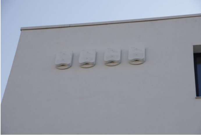
Flachkästen für Fledermäuse auf wärmgedämmter Fassade Quartier Mitte, Passau
